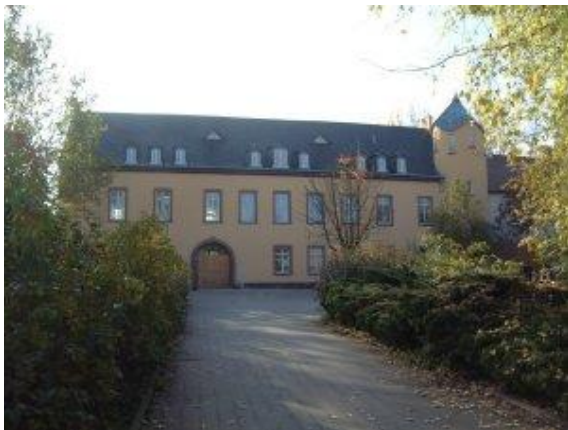
Blick auf die Nordseite von Schloss Ardeck
